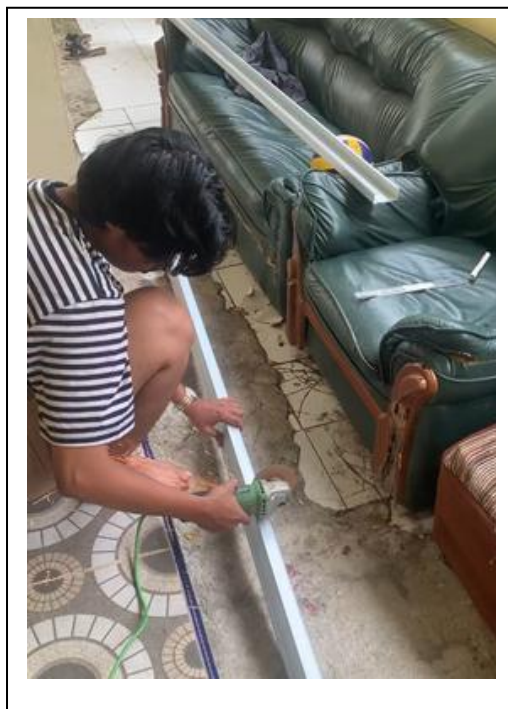
Gambar 1. Pemotongan Baja Ringan
